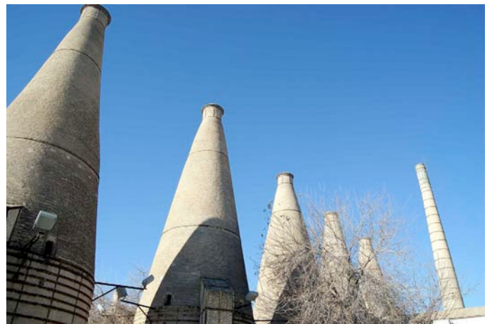
Cheminées de La Cartuja de Sevilla
